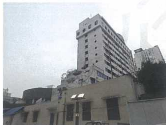
西邻科技大楼
