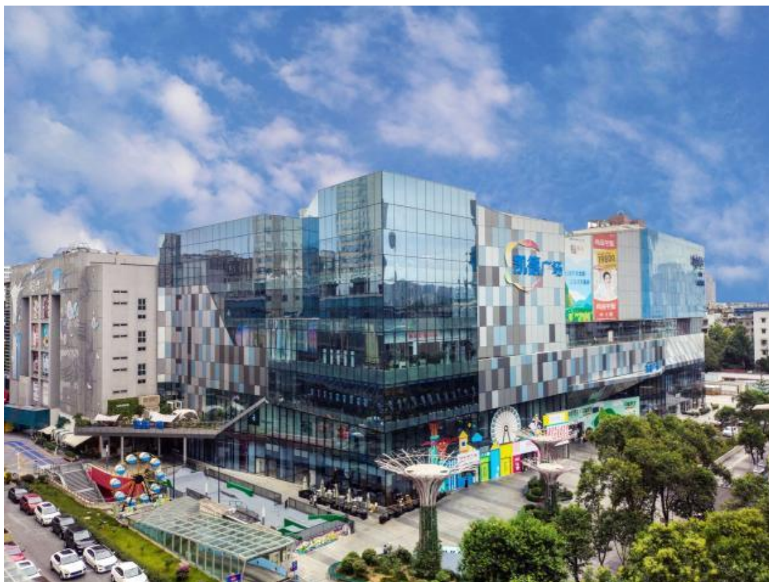
图 5-8 绵阳涪城项目外观
