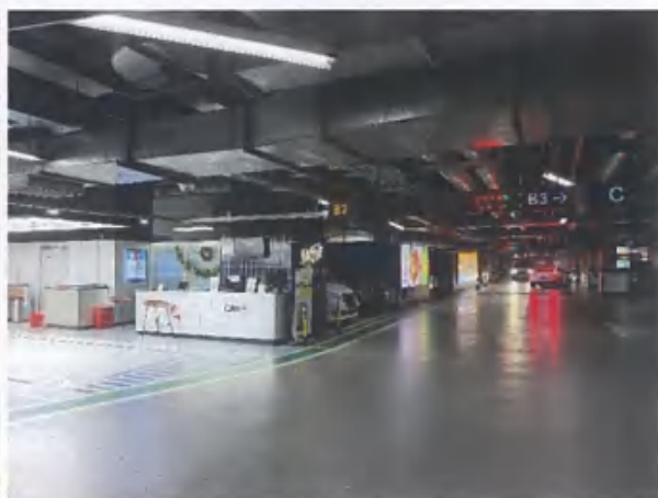
项目地下车库
