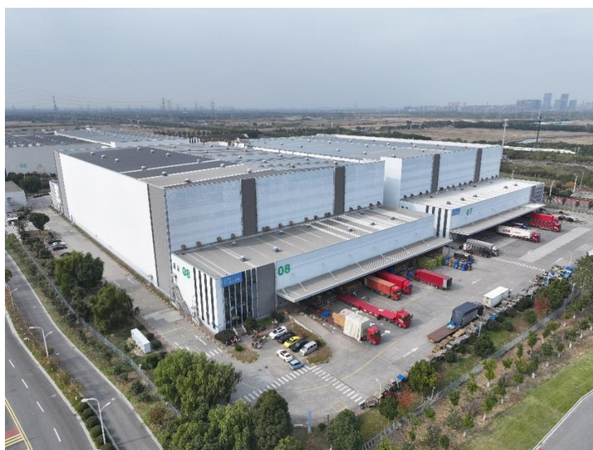
图 5-1-2：不动产项目建筑外观图
