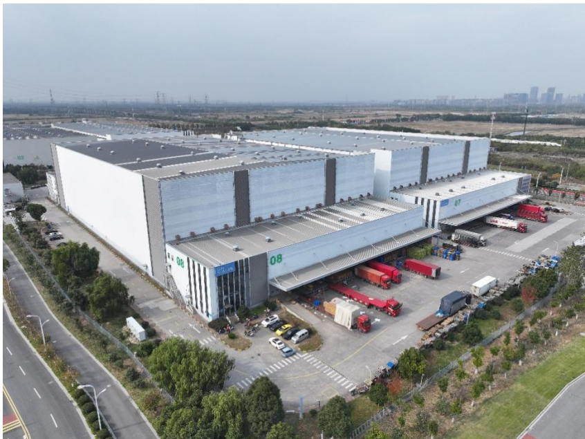
图 2-1-2：不动产项目建筑外观图
